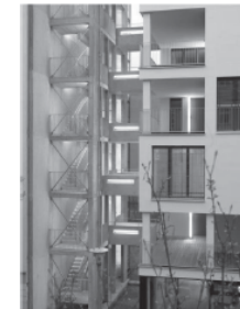
Beispiel: Offenes Treppenhaus, Esmarchstraße, Berlin Kaden und Klingbeil
