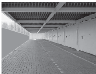
Beispiel für halboffene, mit Terrassen überdeckte Garage nach Kempe Till Architekten, Niederlande
